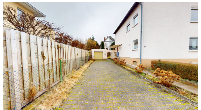
Hofeinfahrt und Garage
